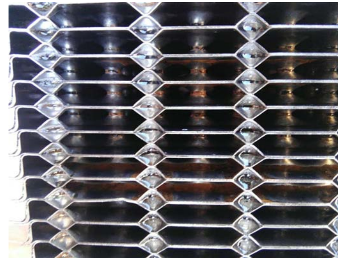
写真11：写真8の洗浄後拡大写真。ほぼ新品同様の表面状態に回復している。銅ロウ付部もしっかりと確認されている。気密テストは、両方の熱交換器ともリークはゼロであった。洗浄には、スス、油の除去用に”ダイナミックGCS”を漬け置き作業で使用。水側のスケール洗浄は、”ダイナミックデスケラー”にて洗浄を行った。
