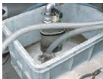
スケールにダイナミックデスケラー が反応している。
