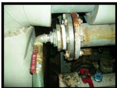
配管を加工して洗浄装置を設置
