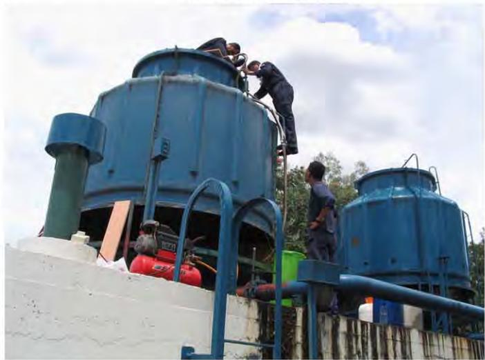
下部温水槽に水中ポンプを設置して上部からシャワーにて薬液を循環させる。
