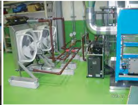
乾燥機用チラー＋ 排熱利用による工場内暖房用ラジエーターの設置
