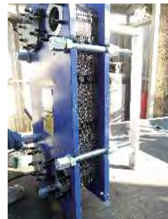
茨城県 食品工場プレート式熱交換器 枚数変更と分解洗浄
