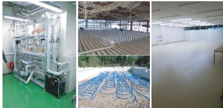
福島県白石市新設工場様 地中熱利用/事務所床暖房/床冷房による200m 2 事務所の省エネ化
