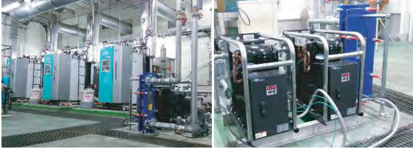
大手食品工場様 大型冷凍機用クーリングタワー熱利用/ボイラー給水加熱 洗浄用温水用2台
