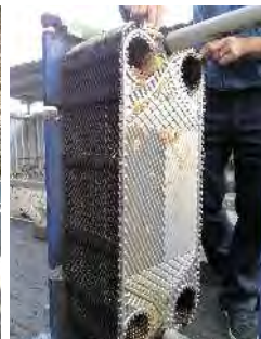
茨城県 食品工場プレート式熱交換器 枚数変更と分解洗浄
