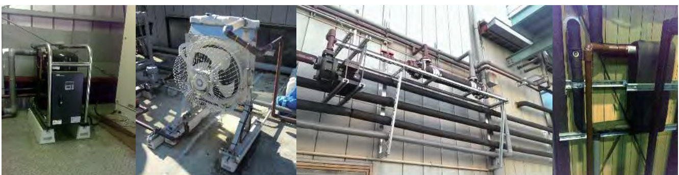
神奈川県 アルミアルマイト工場 ヒートポンプ・ヒートパイプ冷却/加熱による省エネ、水を使わない硫酸槽の冷却＋排熱によるアルカリ槽加熱
