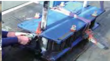
錆びついたテンショニングボルトの切断作業
