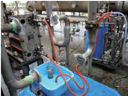
現場における循環洗浄
