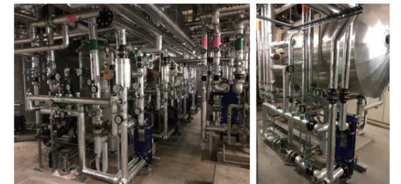
浴槽加温用の高効率熱交換器を既存濾過加温システムに加えた様子(改修後) 給湯補給水用に高効率熱交換器を加えた様子(完成)
